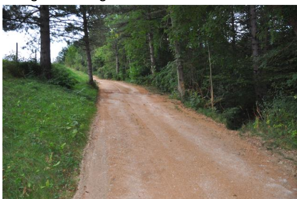
Rosentaler Höh' Wegsanierung
