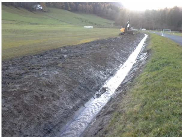
Schrattenbach beim Sportplatz/Trafo (Vor – Nach) Grabenreinigung
