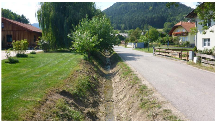
Grabenreinigung in Rosental
