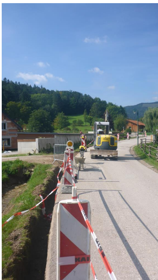
Firma Kaim im Auftrag der Telekom / A1 bei der Errichtung des Glasfaserkabels von Grünbach zum Sender.
