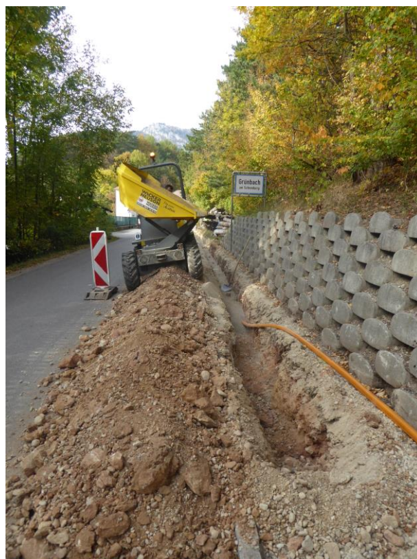
Firma Kaim im Auftrag der Telekom / A1 bei der Errichtung des Glasfaserkabels von Grünbach zum Sender.
