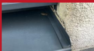
Schadhafter Fensterbankanschluss
